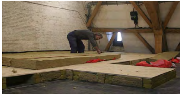
Tijdens de werkzaamheden - november 2011
