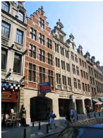
Bergstraat nr. 24 tot 40 – blok 6 'pastiche'architectuurue
