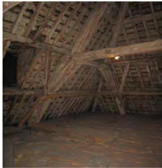
Staat van de zolder vóór de werken van 2011
